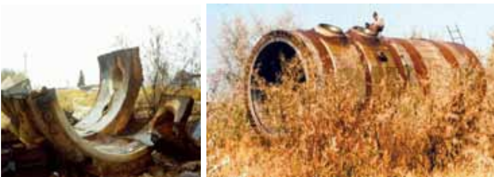
Рис.3 Корпус реактора первого блока КАЭС [7]
